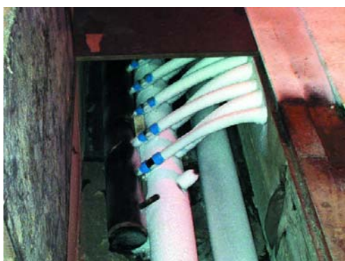
Рисунок 14. Пластиковые соединительные трубы системы распределения и накопления (теплоизолированные)
